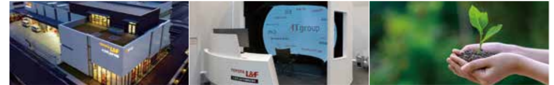
クリーンエネルギーを利用した白金オフィス
